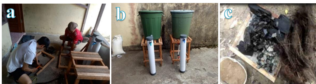
Gambar 1. Persiapan alat dan bahan; (a) pembuatan perangkat, (b) instalasi pengolahan air bersih, (c) bahan filtrasi.
