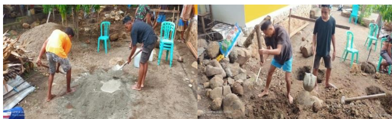
Gambar 5. Proses pembangunan rumah sanggar Mbola So
