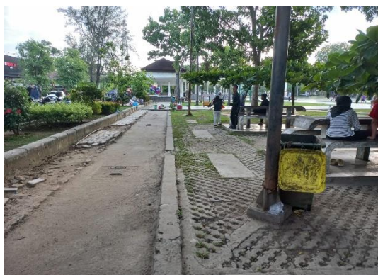
Gambar 17. Kondisi salah satu sudut lapangan kota langsa setelah kampanye
