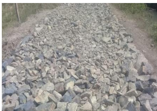
Gambar 4. Pelaksanaan pemasangan batu kali sebagai akses jalan
